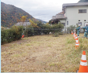
某〇〇広場 伐採工事
