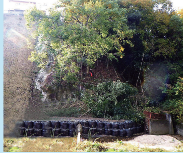
某〇〇様邸 植栽工事
